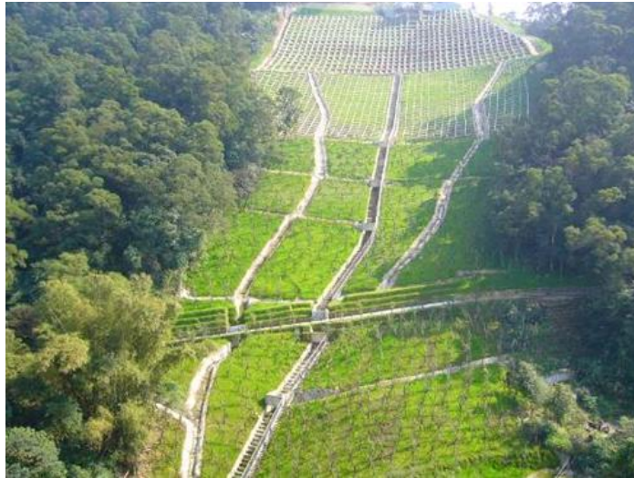
圖 5 T-16 塔柱邊坡整治工法竣工照片(2010 年 8 月)
