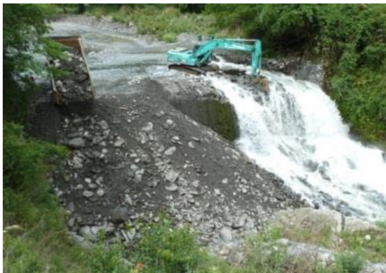
(b) 開始壩體拆除工程 (2011/05/25)
