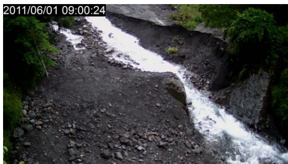
(d) 壩體工程拆除完成 (2011/06/01)
