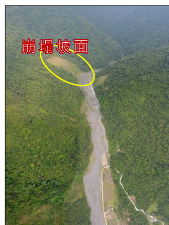
圖 4 寒溪(DF085)坡面崩塌
