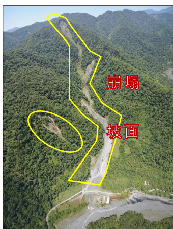
圖 2 寒溪農場邊谷崩塌
