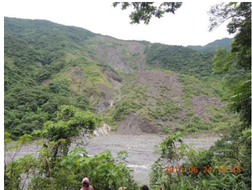
圖 2 DS32 上游潛在崩塌地
