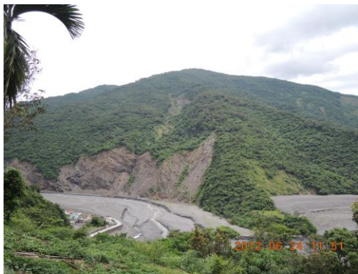
圖 1 DS32 潛在崩塌地
