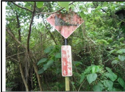
7. 位於無名橋(三)旁土石流警示牌模糊不清(308523,2768448)
