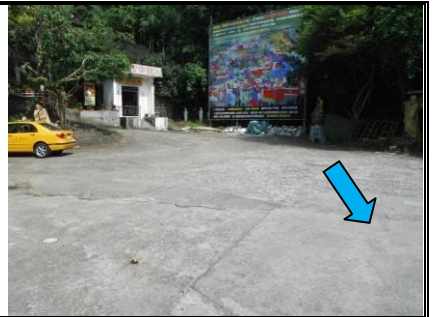
9. 右側支流流經道路下方箱涵排入下流(308597, 2768422)
