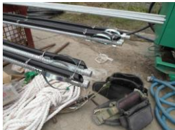
置入 D19 鋼筋後注入水 泥砂漿
