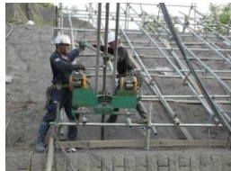
坡面鑽設孔位
