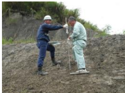
施作前-SPT 貫入試驗
