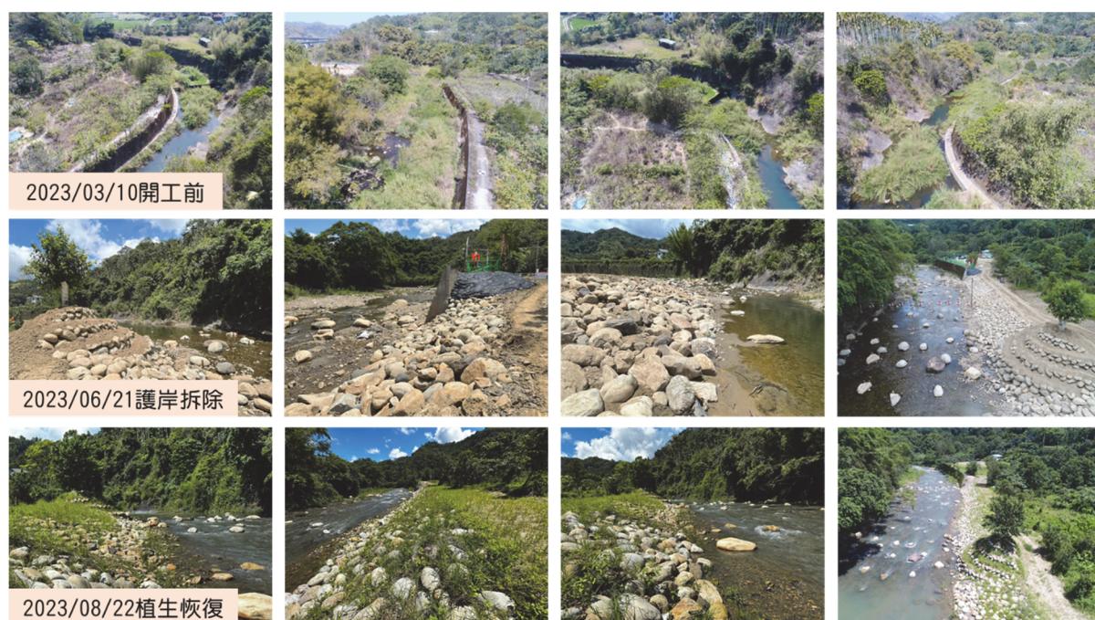
圖 16 種瓜坑溪還溪於野工程一期施工前中後環境復育概況
