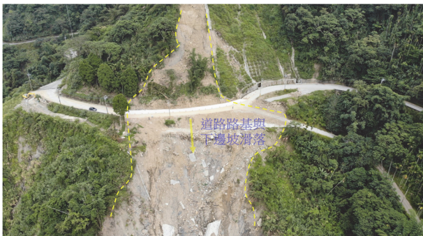
圖 2 災害時崩塌照片 (謙和工程顧問有限公司，2021 年 8 月)
